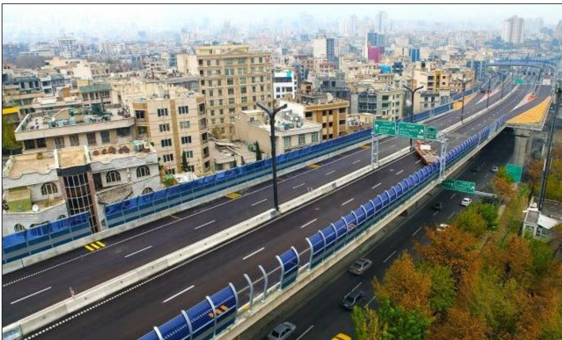
شکل ۲-۲- نمونه یک تندراه بالاگذر (بزرگراه صدر، تهران)
