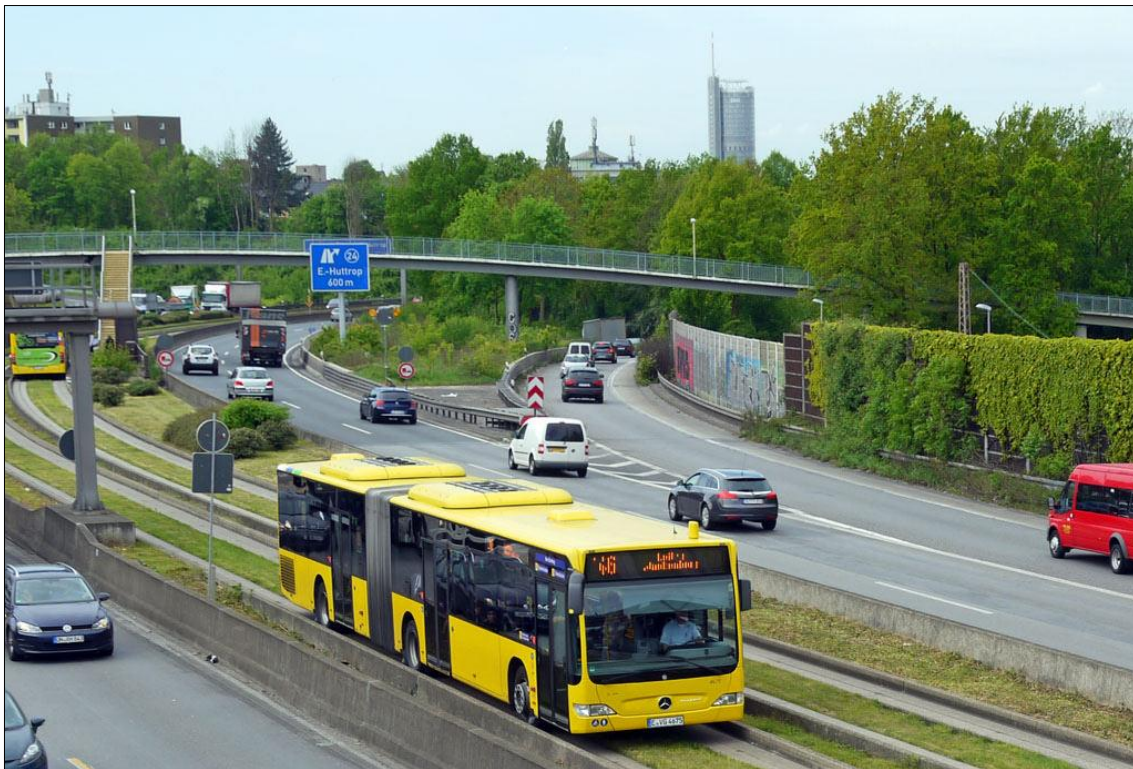
شکل ۱۶-۱- مسیر ویژه سیستم هدایت مکانیکی اتوبوس
