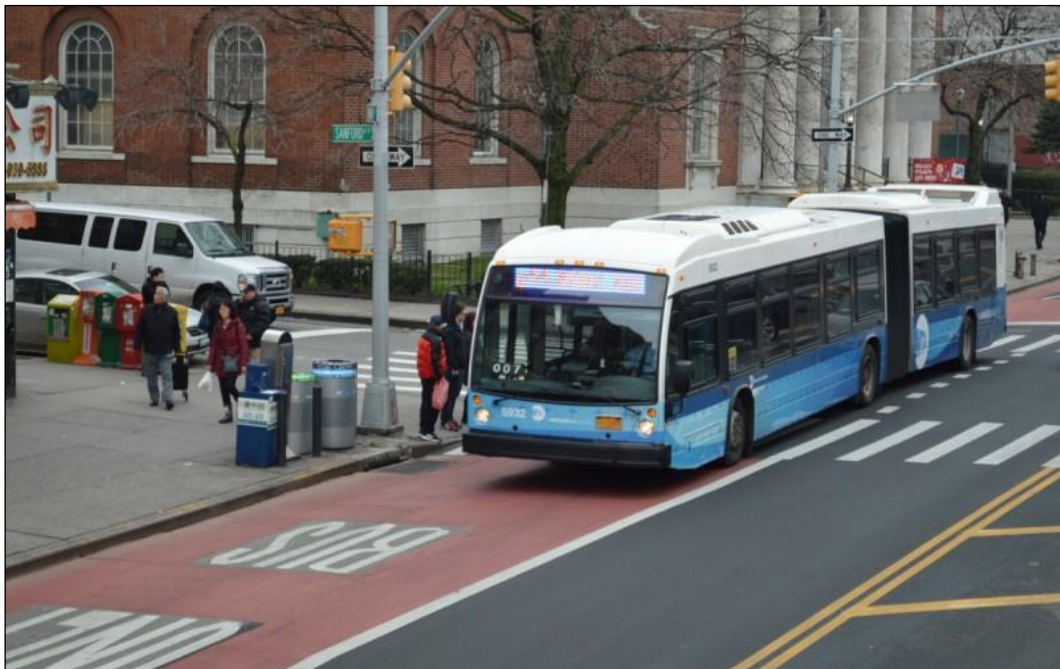
شکل ۳-۵- نمونه خط ویژه اتوبوس جدا شده با خط‌کشی در سمت راست خیابان
